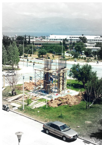
Η κατασκευή με τα δύο τεμνόμενα «Π» αναγείρεται κοντά στην Πρυτανεία
