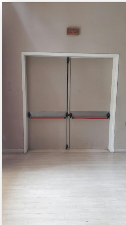
Εικόνα 5 : Υφιστάμενη ξύλινη θύρα εισόδου αμφιθεάτρου ΑΑ
