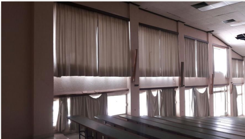
Εικόνα 6 : Υφιστάμενες κουρτίνες προς αποξήλωση αμφιθεάτρου ΒΑ
