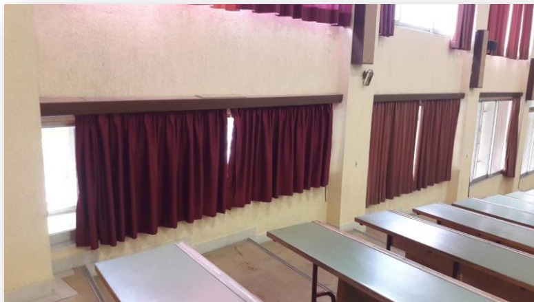
Εικόνα 4 : Υφιστάμενες κουρτίνες προς αποξήλωση αμφιθεάτρου ΑΑ
