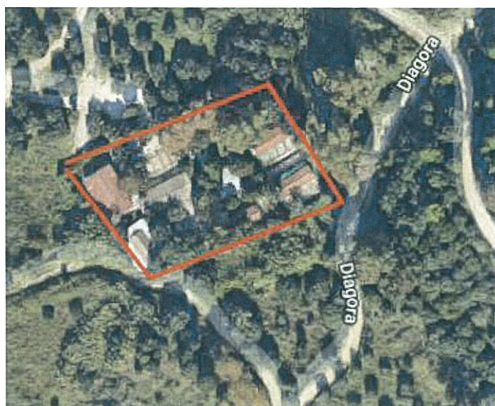
Εικόνα 2. Παρέμβαση στον πρώην χώρο Μέριμνας Ζώων
