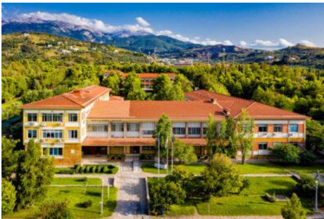
Κτίριο Διοίκησης (Κτίριο Α), Ρίο
